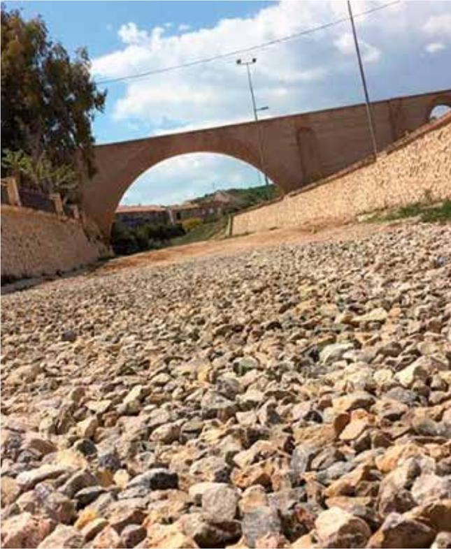
La Concejalía de Aguas y Alcantarillado ha acometido diferentes obras de adecuación del cauce de la rambla de La Santa a su paso por el casco urbano, a la altura de la zona del Arco de las Ollerías, para solucionar los problemas de estancamiento de aguas en superficie y el encauzamiento de la escorrentía a la red de alcantarillado.
